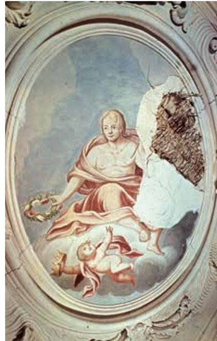
Abb. 4: An einer Schadstelle des Freskos in Schloss Hundisburg wird der Aufbau unterhalb der Malschicht sichtbar: Über der Holzkonstruktion sind Schilfrohrmatten angebracht, auf denen der grobe Unterputz haftet. Die Oberfläche des *arriccio* zeigt eine Unterzeichnung.
