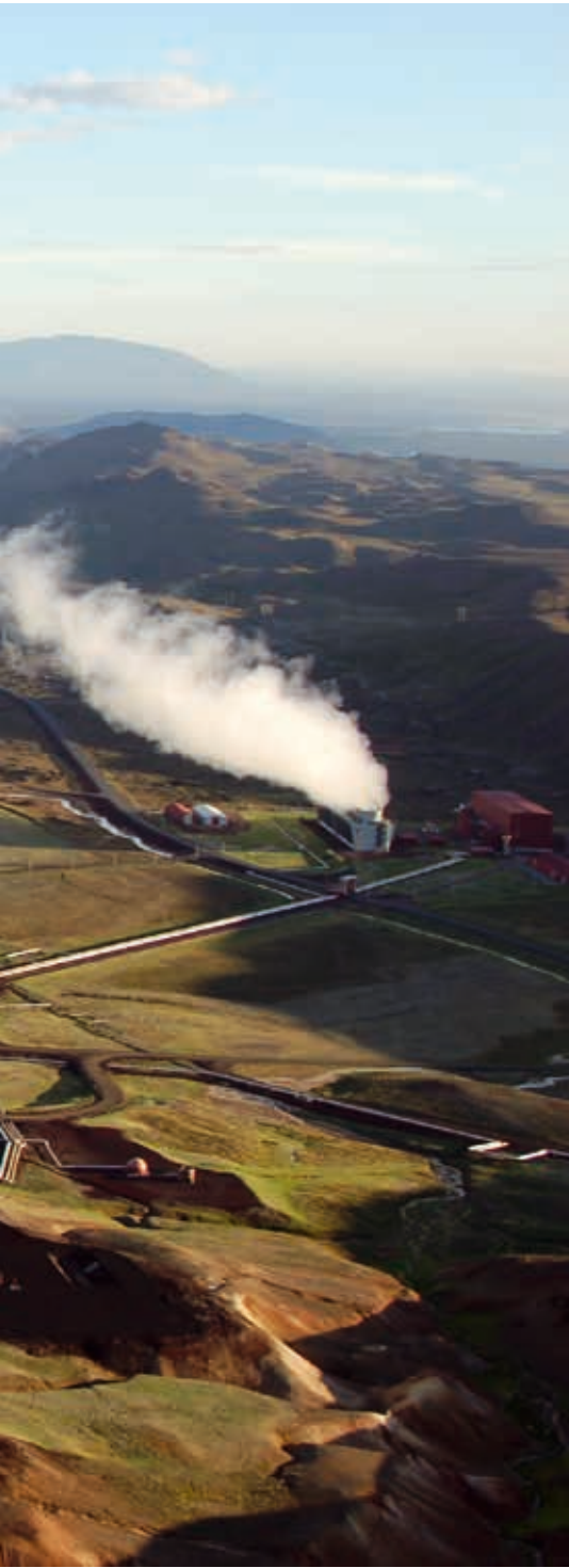
Luftaufnahme des geothermischen Kraftwerks bei Krafla im Norden Islands. In der Ebene wurde bereits 2007 versucht, in rund 4 km Tiefe erstmals nach überkritischem Wasser zu bohren, was jedoch nicht gelang. Überkritisches Wasser könnte bis zu zehnmal mehr Strom liefern als herkömmliche geothermische Kraftwerke auf der Insel. (Quelle: www.scinexx.de )
