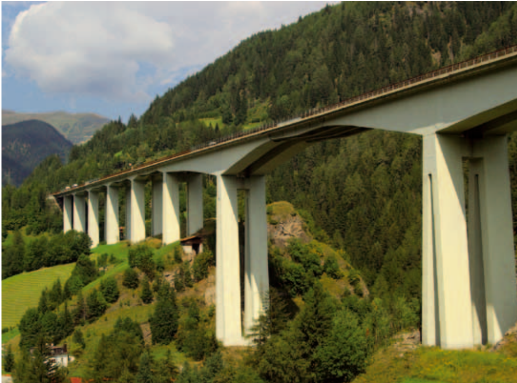
Abb. 2: Sechsspurige Autobahn mit zahlreichen Brücken über den Brennerpass (Alpen).
