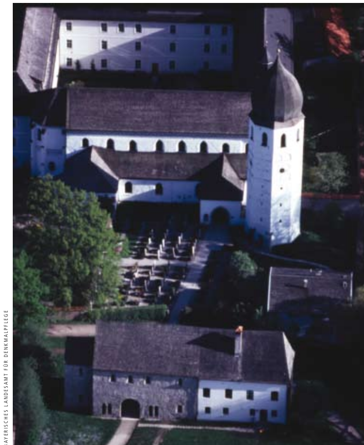
Abb. 1: Die Torhalle mit der Nikolauskapelle im Erdgeschoss und der Michaelskapelle im Obergeschoss; im Hintergrund links der Campanile. Von Nord-osten gesehen.
