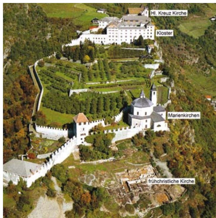
Abb. 2: Oberes Drittel des Burgberges. Von Süden.
