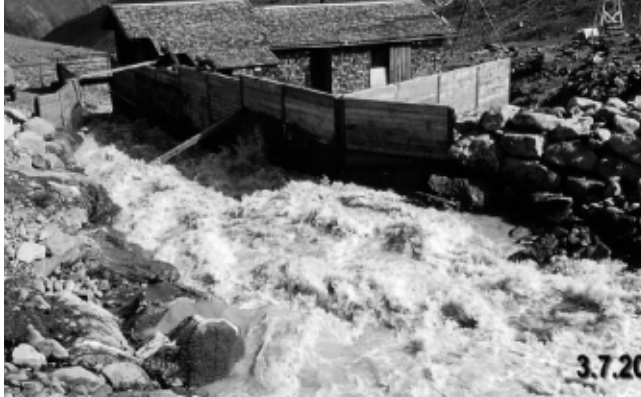
Die neue Hochwasserverbauung an der Pegelstation der Akademie-Glaziologen auf dem Vernagtferner in 2635 m Höhe.
