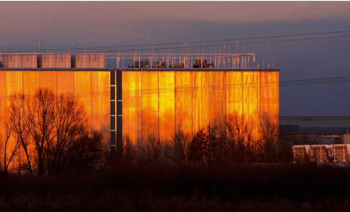
Archivierung und Langzeit-speicherung digitaler Daten sind ein zentraler Service des Leibniz-Rechenzentrums in Garching.
